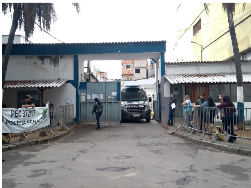
Figura 1: Portão de acesso - tirada em 05/10/2018, acervo pessoal
