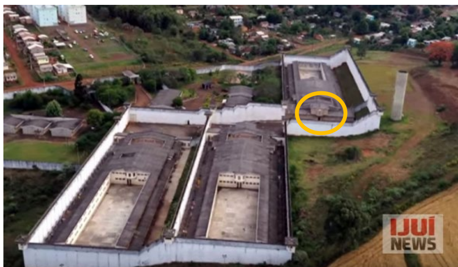
Figura 1. Foto do Google sobre a construção da Penitenciária Modulada Estadual de Ijuí
