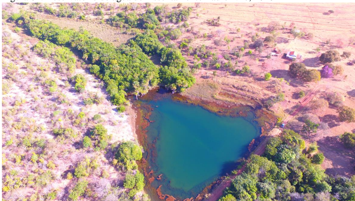
Figura 01: Reservatório de água do Assentamento Padre Nilo, 2018
