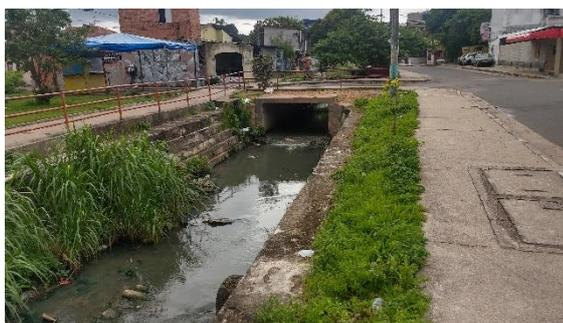
Foto: O igarapé da Sapolândia após as ações do PROSAMIM. Nota-se o total assoreamento e contaminação das águas.
