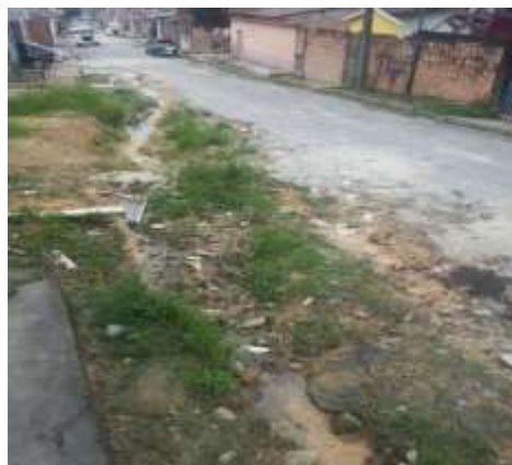
Ruas de acesso precárias
