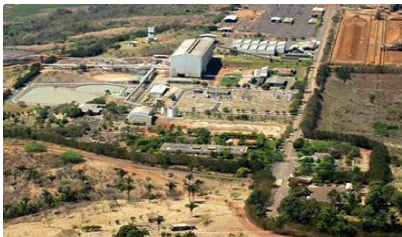
Ampliação da rede elétrica em Catalão (Goiás) que beneficiará o complexo mineroquímico de fertilizantes na região. (VALE, 2014)
