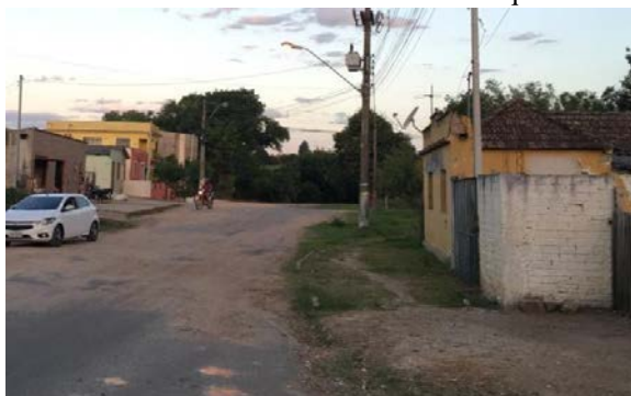
Fotografia 4 – Estado atual da rua Clarestino Bento quatro anos após a inundação
