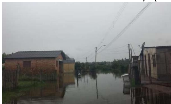
Fotografia 7 – Seguimento da rua Alfredo Porciúncula com afetação pelo evento de inundação em 2019
