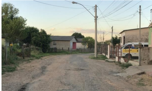
Fotografia8 – Situação atual da rua Alfredo Porciúncula quatro anos após o evento de inundação
