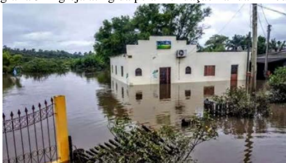
Fotografia 5 – Igreja atingida pela inundação na rua Alfredo Porciúncula
