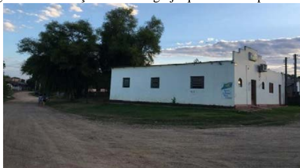
Fotografia 6 – Situação atual da igreja quatro anos após o desastre
