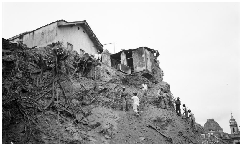
Figura 02 – Desmorte do Morro Santo Antônio
