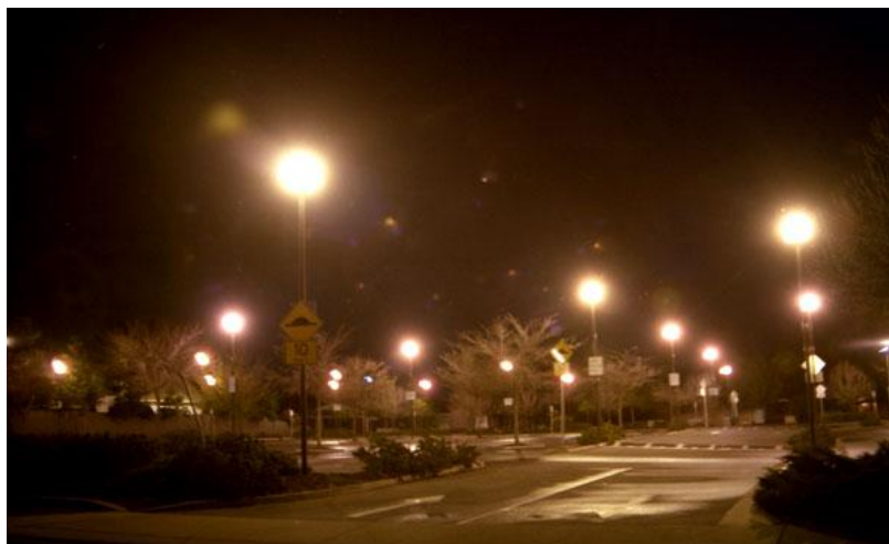
FIGURA 3:Exemplo de Ofuscamento por luminárias num estacionamento
