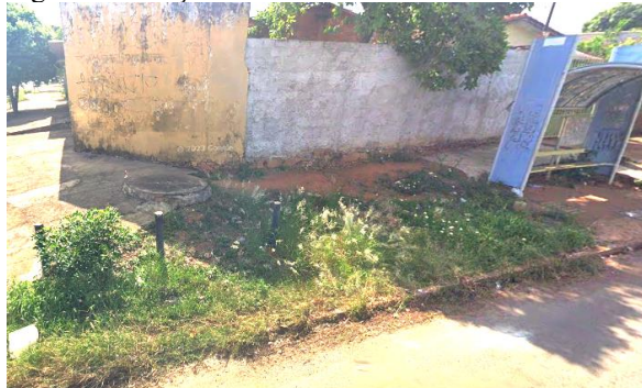
Figura 02: Calçada da Rua JM 26
