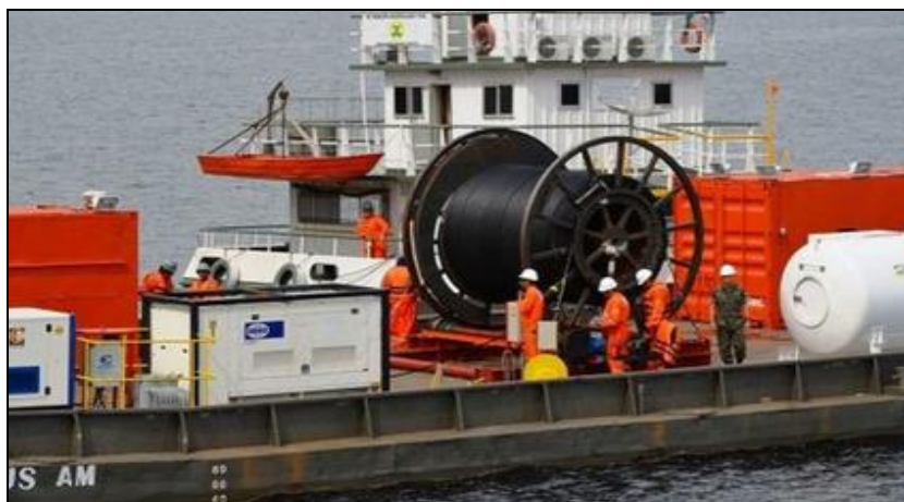
Figura 4 - Lançamento dos cabos de fibra óptica no Rio Negro
