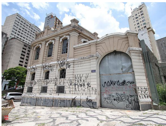
Figura 4. Fachada lateral da São Paulo Tramway, Light and Power Company . Fonte: http://www.saopauloantiga.com.br/subestacao-riachuelo/
