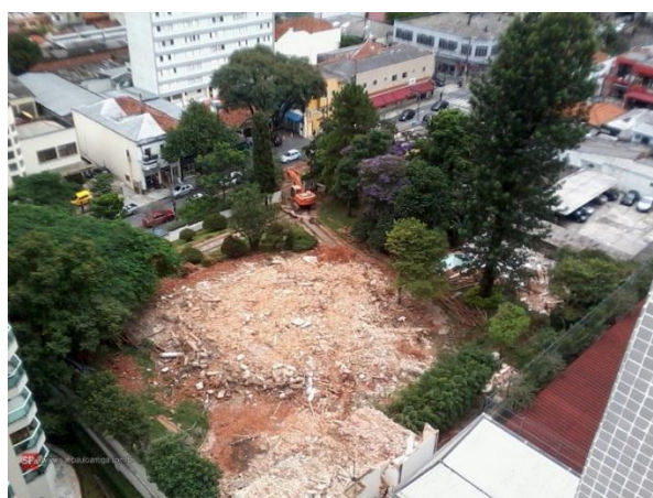
Figura 2. Demolição do imóvel localizado na Rua João Moura, 740. Fonte: Google imagens
